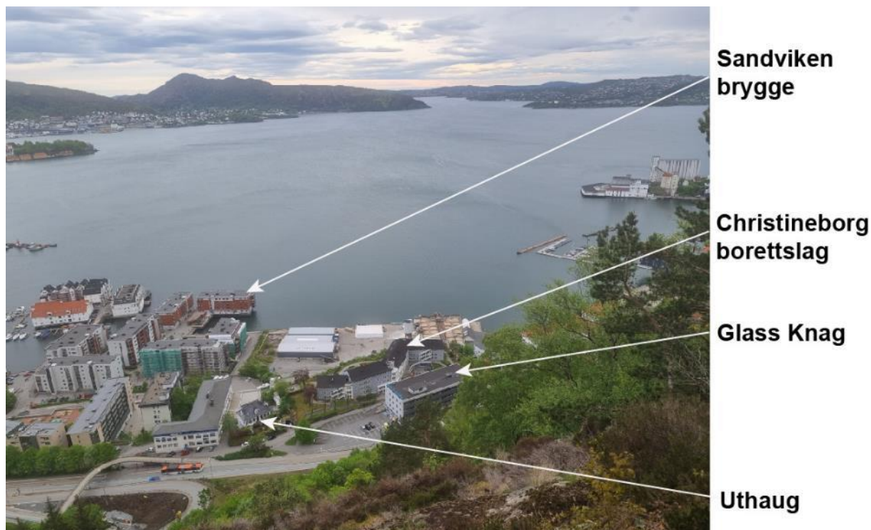
Figur 5-5 Oversiktsbilde over området. Bildet er tatt før Saltimport AS flyttet fra tomten (Bilde: Asplan Viak AS).
