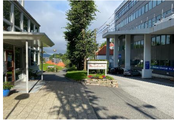
Figur 5-12; Christineborg borettslag t.v. og Glass Knag med deler av eksisterende rampe t.h. Sett mot nord.
