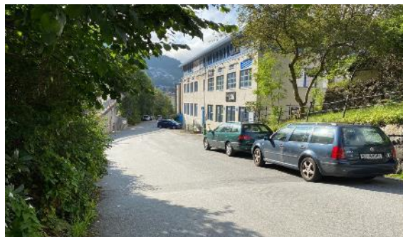
Figur 5-18; Næringsbygg i Sandviksveien 110.
