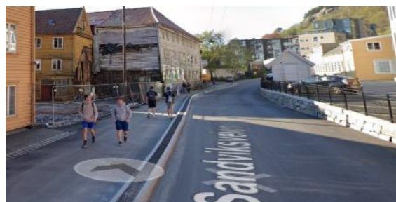
Figur 5-41: Fra Gjensidigekrysset og videre innover Sandviksveien er det fortau på vestsiden av veien. Fortau er skilt fra kjørevegen med en smal kantsteinsrabatt frem mot krysset med Måseskjærveien.
