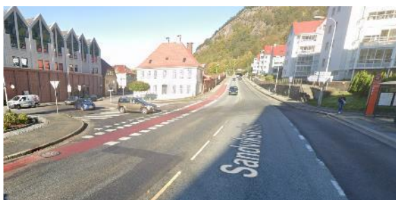
Figur 5-40: Dagens Gjensidigekryss er et forkjørsregulert T-kryss. Krysset er et av de mest ulykkesutsatte kryssene i Bergen, og det er særlig ulykker med venstresving inn og ut som medfører ulykker. Det er i dag supplert med skilt som viser typisk ulykkesforløp. Det foreligger planer om å signalregulere krysset. Disse planene ligger til grunn for trafiksikkerhetsvurderingen.
