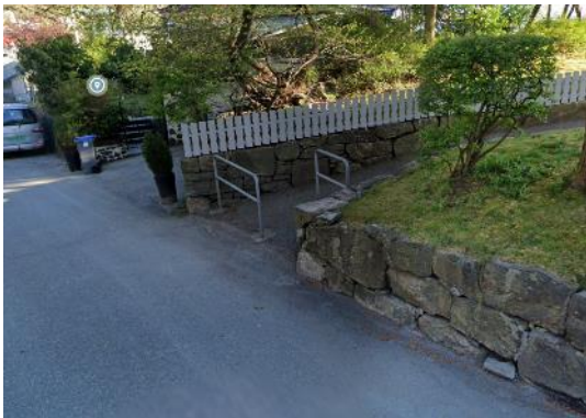
Figur 7-2: Siktforhold inn til eksisterende gangveg ved Christineborg borettslag (fra Google Street View).
