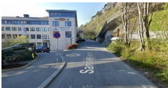
Figur 5-42; Videre fra kryssområdet med Måseskjærveien fortsetter fortauet langs Sandviksveien som et ordinært fortau opphøyd med kantstein. Dette går videre til Sandviksveien 94 før det stopper.
